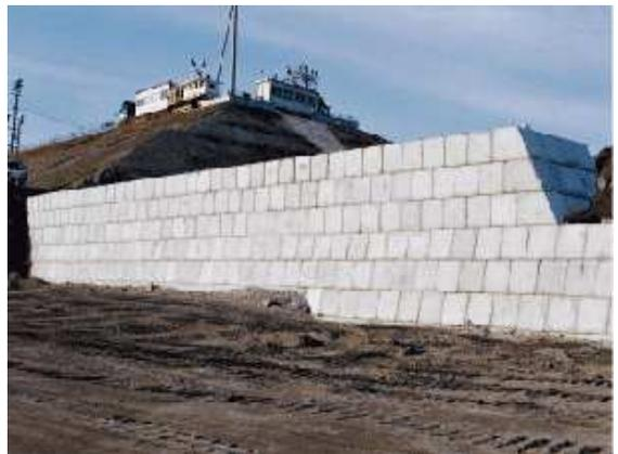
● 鎧ブロック（神通川水系砂防事務所／白谷第6号砂防工事／砂防堰堤）
