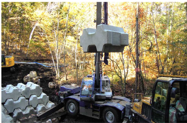
写真 1 ラフテレーンクレーンによる吊り上げ
