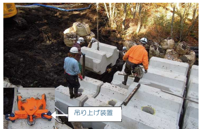
写真 2 吊り上げ装置を利用した据え付け
