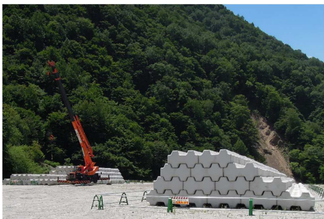
写真 5 備蓄ヤードでの保管状況
