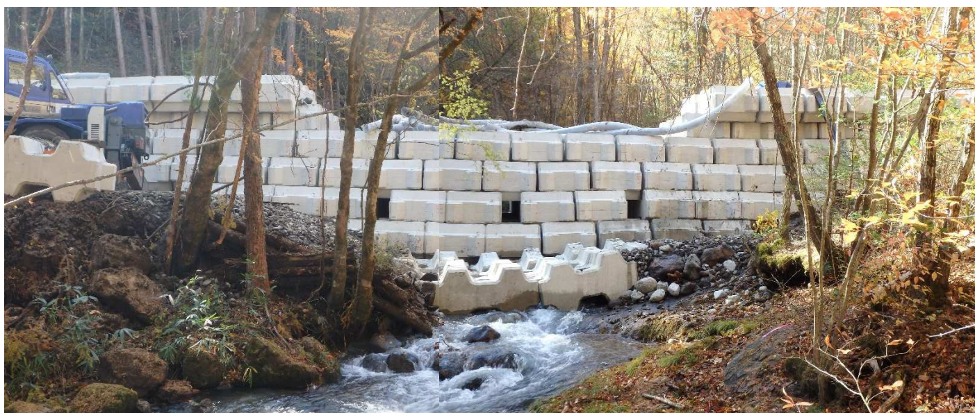
設置がほぼ完了したビーハイブ 4t型による砂防堰堤（10月28日撮影）
