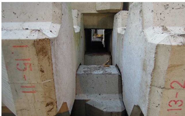
写真 3 下流の水利用に配慮した水抜き穴
