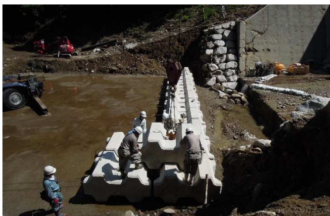
ビーハイブ 4t型を活用した堰堤工施工中 (平成 26年 8月 1日据付着工)
