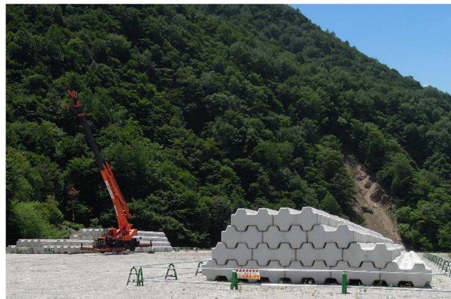
南木曾町土石流災害緊急応急対策に活用された備蓄ブロック（ビーハイブ4t型）
