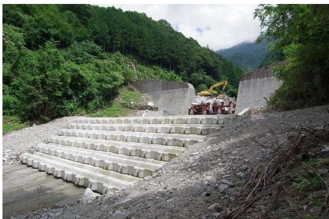
据付完了したブロック堰堤工 上幅 20m, 高さ約 5m, ブロック 347 個 (平成 26年 8月 6日据付完了)
