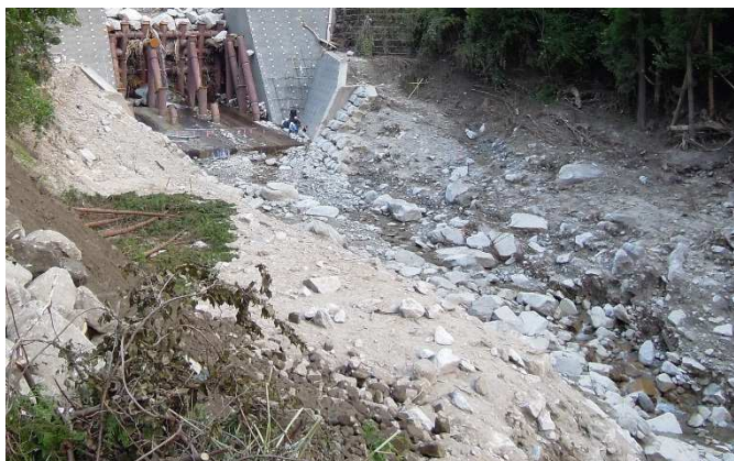
応急対策ブロック堰堤工の着工前の 梨子沢第一砂防堰堤下流部
