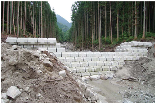
南木曾町土石流災害緊急応急対策として大梨子沢合流地点上流の小梨子沢に構築された堰堤工（上幅28m、高さ約4m、ブロック261個）
