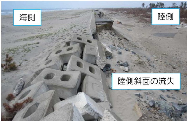
海岸堤防の被災状況 (H23 撮影)
