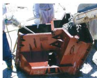
⑤コンクリート打設
