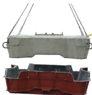
脱型・中筒取り外し
