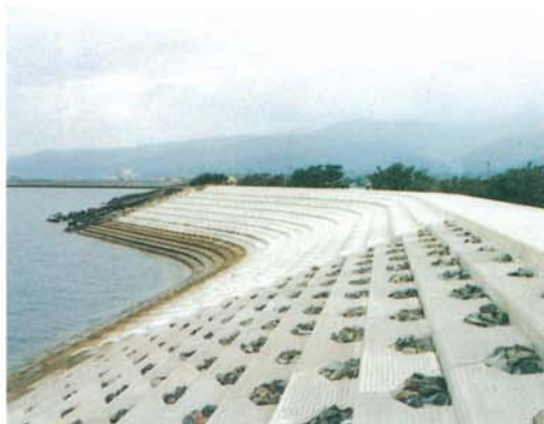
出水海岸 鹿児島県出水土木事務所／3割型／ n=1:2.5 R=28.2in, 37.3out
