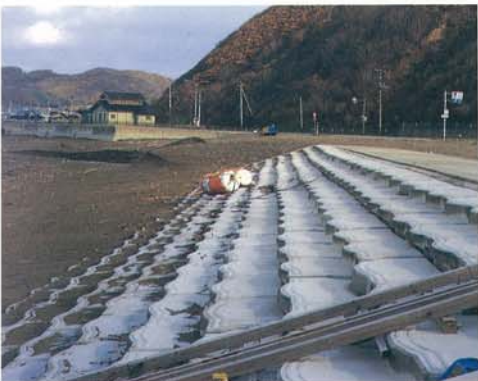
泊海岸 北海道函館土木現業所／3割型／ n=1:3
