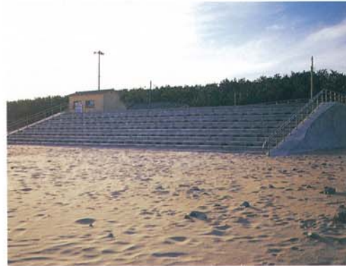
四倉海岸 福島県いわき建設事務所／3割型／ n=1:3
