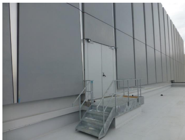
本館事務棟 遮蔽扉
