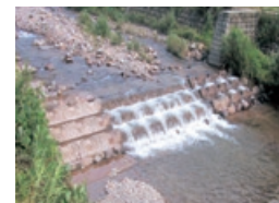
魚道ブロック
