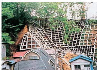
フリーフレーム工法（現場打吹付法砕工）
